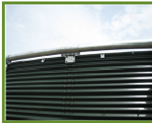
Vahvistettu siilon seinä
