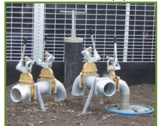
Venttiili, joka johtaa suuttimeen ja täyttöpisteeseen
