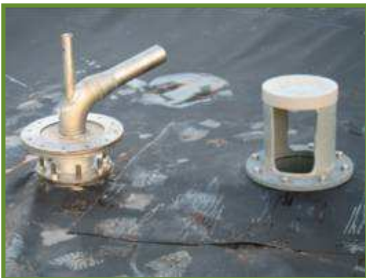
Sekoittimen suutin + täyttökohta pohjassa
